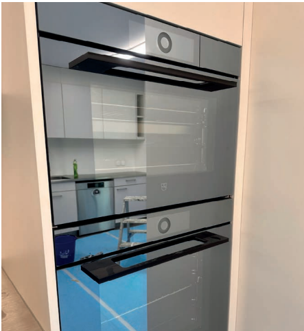
Neue, moderne Küche der Mehrzweckhalle
