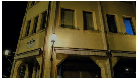
Unnötige Fassaden- und Himmelbeleuchtung
