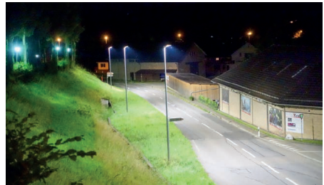
Schlecht fokussierte Strassenbeleuchtung
