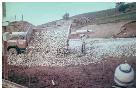
Zusätzliche Arbeiten, wegen dem sandigen Boden
