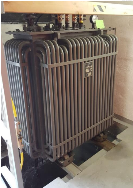
Der Transformator (Bild links) in der Trafostation Storchacker ist ebenfalls zu ersetzen.
