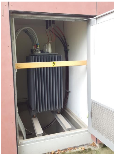
Der Transformator (Bild links) beim Flugplatz ist in die Jahre gekommen und soll ersetzt werden.
