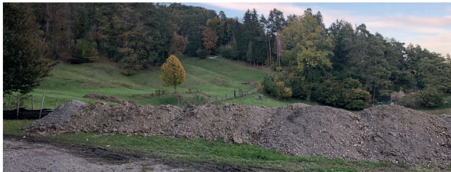
Deponie Aushubmaterial auf dem Funkenplatz
