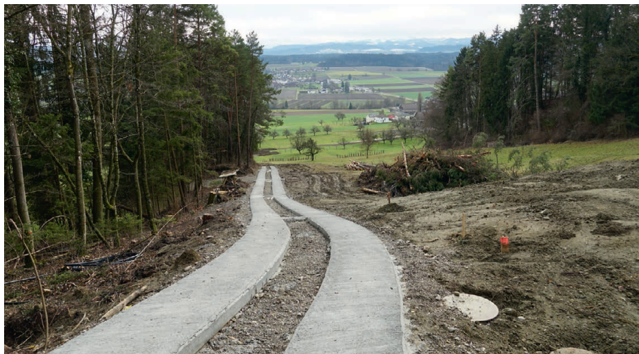
Zufahrt im steilen Gelände
