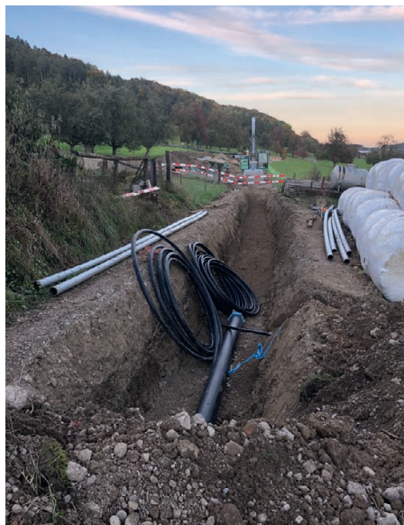
Bau der Wasserleitung östlich von Wein- garten Richtung oberer Tobelhof (Stand Oktober 2020)
