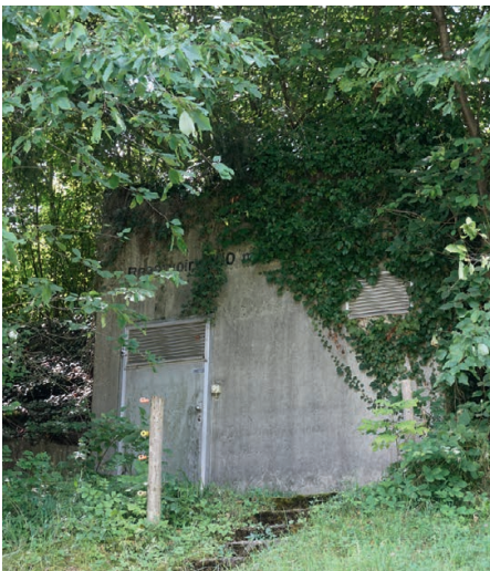
Das alte Wasserreservoir
