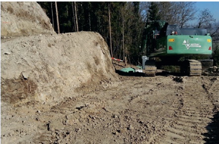
Eine terrassenartige Abgrabung
