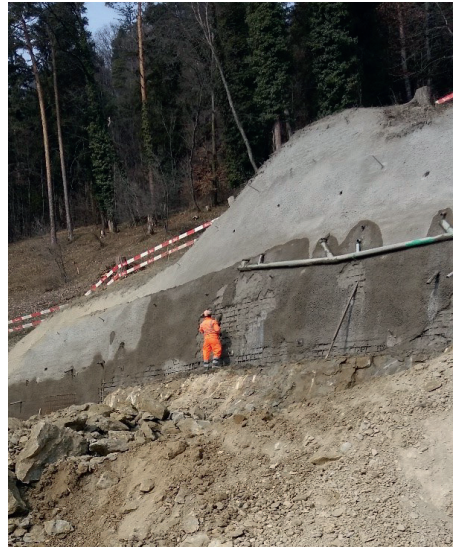
Durch die Löcher wird Wasser abgeleitet.
