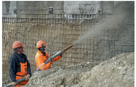
Zur Stabilisierung wird Beton gespritzt.
