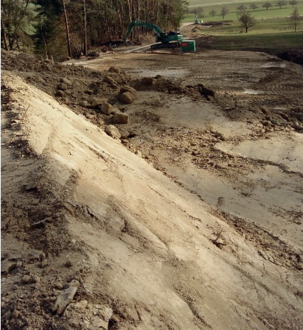
Humus wurde abgetragen
