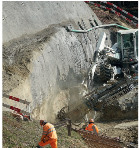
Mit diesem Ankerbohrer wurden acht Meter tiefe Löcher in den Felsen gebohrt und zur Stabilisierung mit Eisen und Beton gefüllt.
