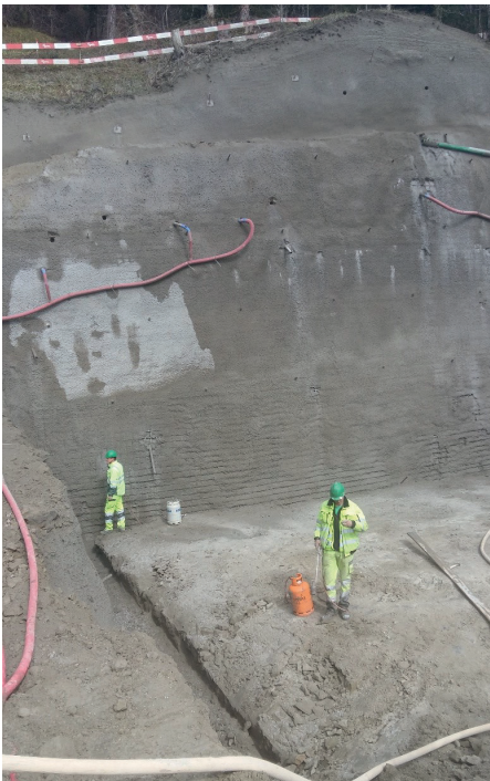
Fertigstellung der Felswand
