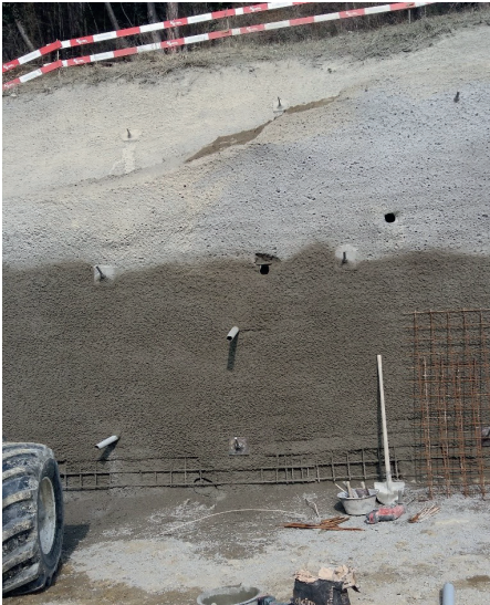
Spritzbetonwand mit Löchern
