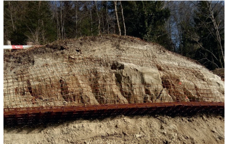
Armierung der Felswand
