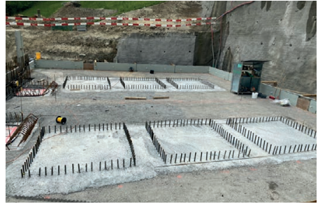
Fundamente für die Pfeiler die die Decke tragen
