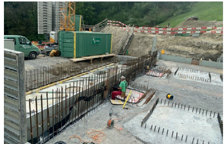
Der Eisenleger an der Arbeit
