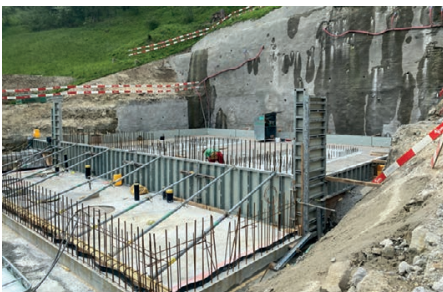
Der Technikraum, vorne, ist schon betoniert.
