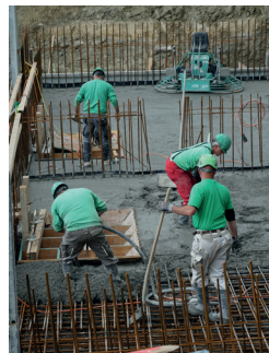
Die Bodenplatte des Reservoirs wird betoniert. (Stand: 20.05.21)
