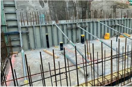
Abschalung und Differenzschalung für die Bodenplatte der Wasserkammer
