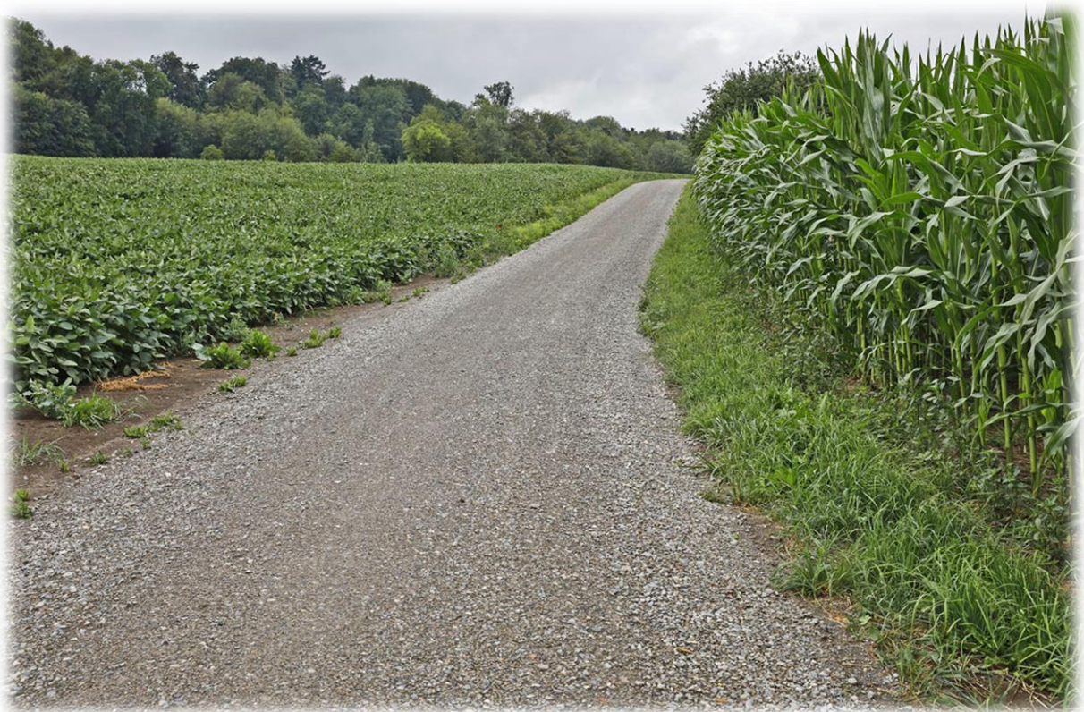
Beispiel einer instand gestellten Flurstrasse
