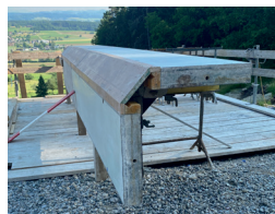
Bild links: Spezielles Schalungselement im 45° Winkel
