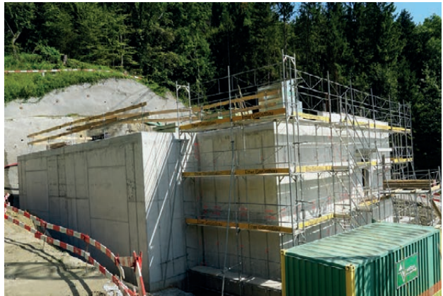
Der Rohbau ist ausgeschalt.
