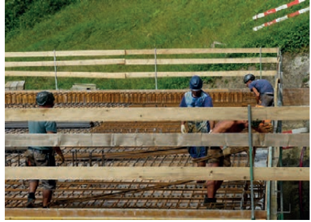
... wurde die Decke betoniert.
