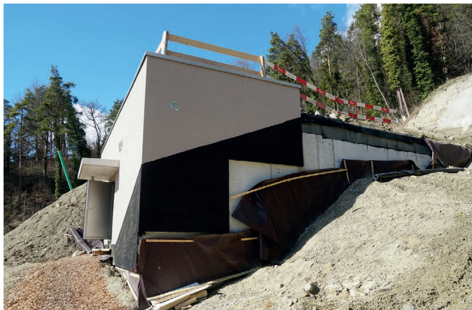
Die Umgebung wird aufgefüllt und angepflanzt.
