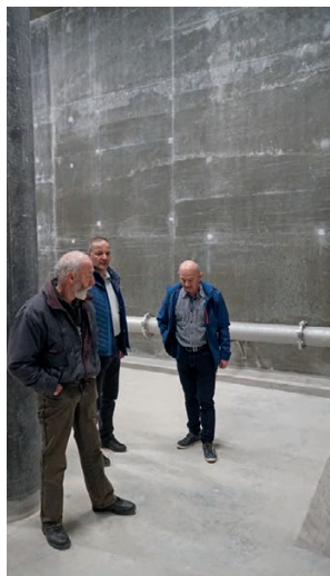
Die 500m³ fassenden Wasserkammern sind noch leer.
