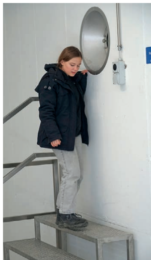
Guckloch in eine Wasserkammer
