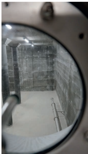
Blick durch das Guckloch in eine Wasserkammer
