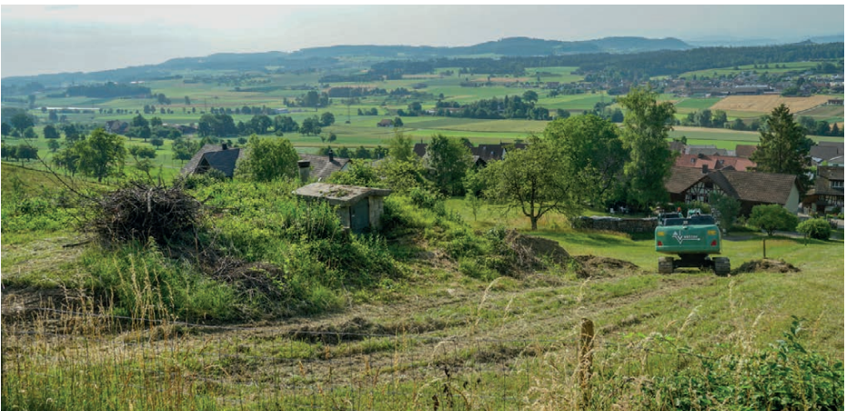
Der Graben für den Elektroverteiler wird erstellt.
