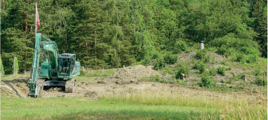
Als erstes wird der Graben für den Elektroverteiler erstellt
