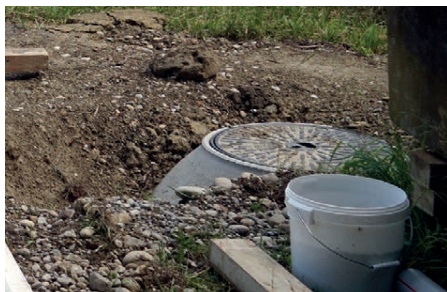
Elektro Verteilschacht
