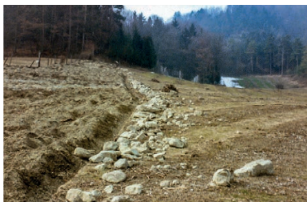
Die 17 Parzellen wurden mit einem Trax in- nert 100 Stunden gleichmässig eingebnet.
