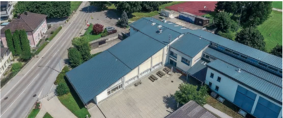
Sanierung der Mehrzweckhalle
