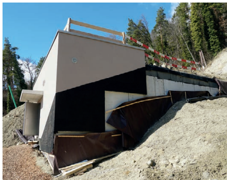
Neubau Wasserreservoir Weingarten
